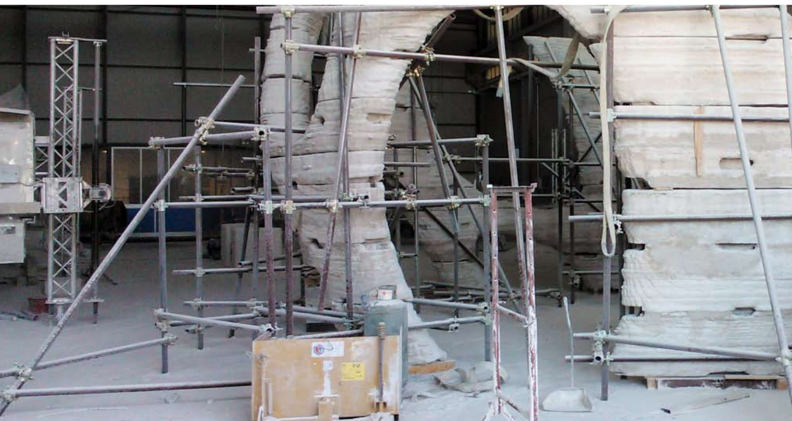
Progetto grafico di Radiolaria , forma creata ad hoc per esaltare il potenziale della stampante D-shape . Sotto: Stampa 3D di Radiolaria .
