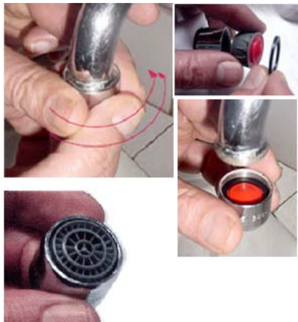
Figura 1. Dispositivo riduttore evidenziato nelle sue caratteristiche fondamentali.
